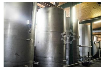
Faser-Wäscherei/Färberei mit Peripherie ca. € 30'000
